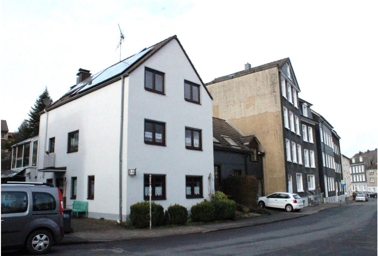
Abbildung 13: Bebauung in der Talsperrenstraße, Quelle: Eigene Aufnahme vom 17.02.2021
