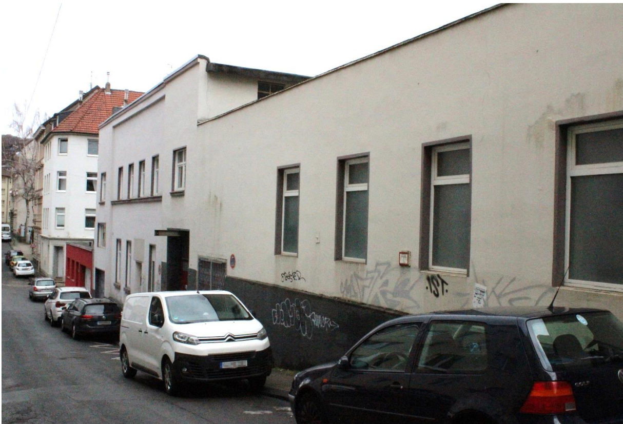
Abbildung 57: Eingeschossiges Gewerbe in der Bandstraße, Quelle: Eigene Aufnahme vom 17.02.2021
