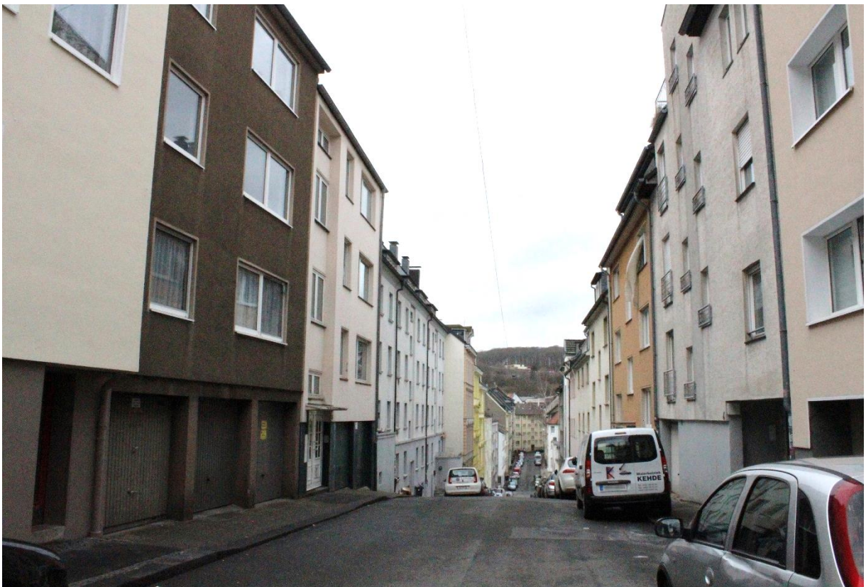
Abbildung 55: Blick in die Bandstraße, Quelle: Eigene Aufnahme vom 17.02.2021
