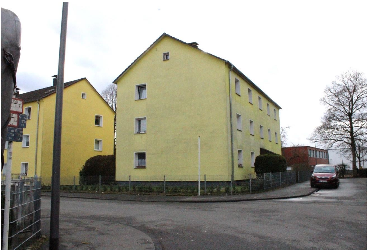
Abbildung 27: Verputzte Mehrfamilienhäuser in der Langwilerstraße, Quelle: Eigene Aufnahme vom 17.02.2021
