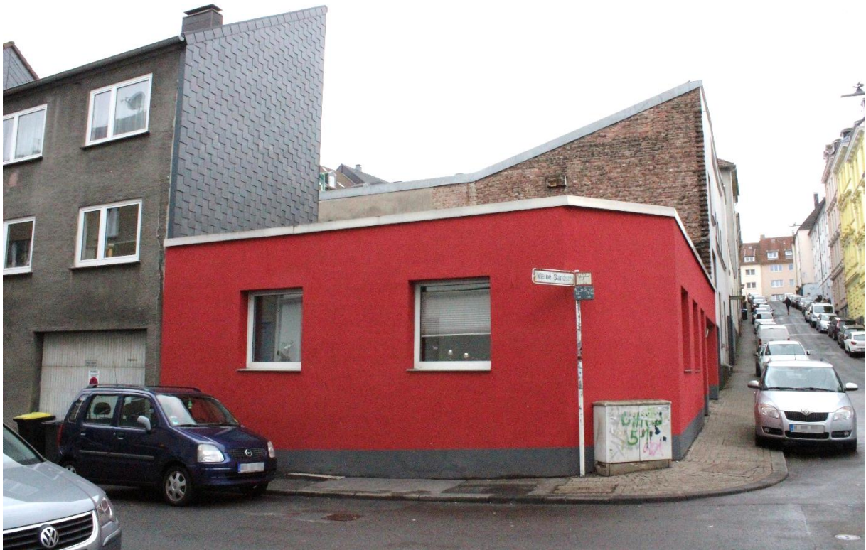
Abbildung 58: Büroräume Ecke Bandstraße / Kleine Bandstraße, Quelle: Eigene Aufnahme vom 17.02.2021
